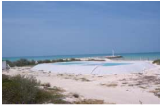
Figura 2.- Reservatório de água da UMDI-UNAM.
